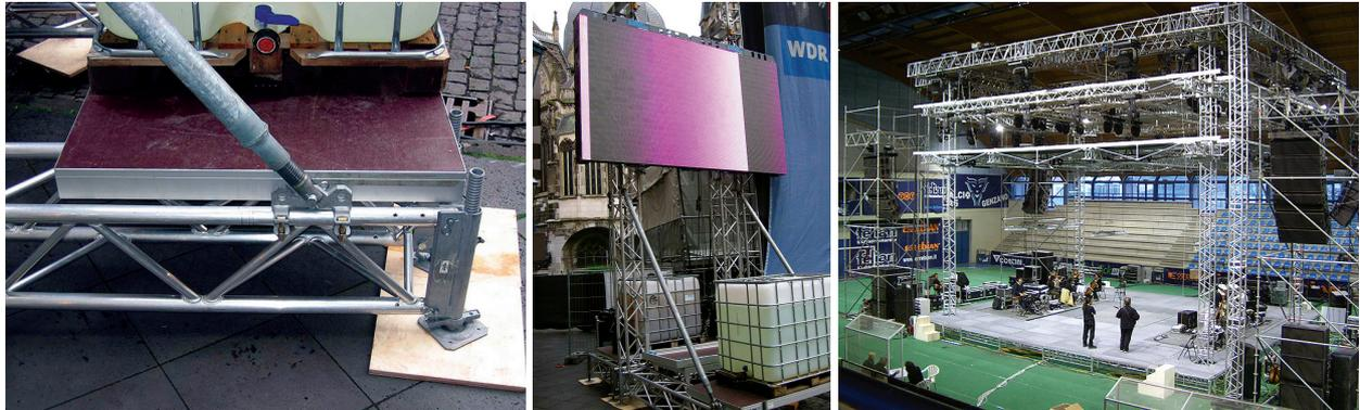
**Mit Ground-Support Riggs sind Systeme gemeint**, bei denen Traversenrahmen auf Stützen stehen und zur Aufnahme von Deko-Elementen, Scheinwerfern, einer LED-Wand usw. dienen. Im Allgemeinen werden hier wie im Veranstaltungsbereich üblich hauptsächlich Aluminiumtraversen verwendet.
